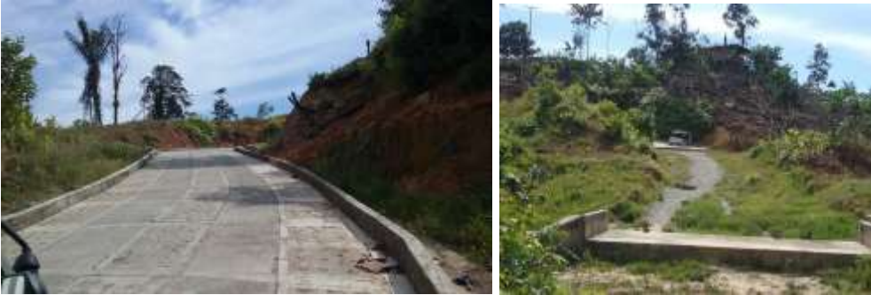
Fotografía 3-3 Vía existente entre el casco urbano de Timbiquí y Bubuey
