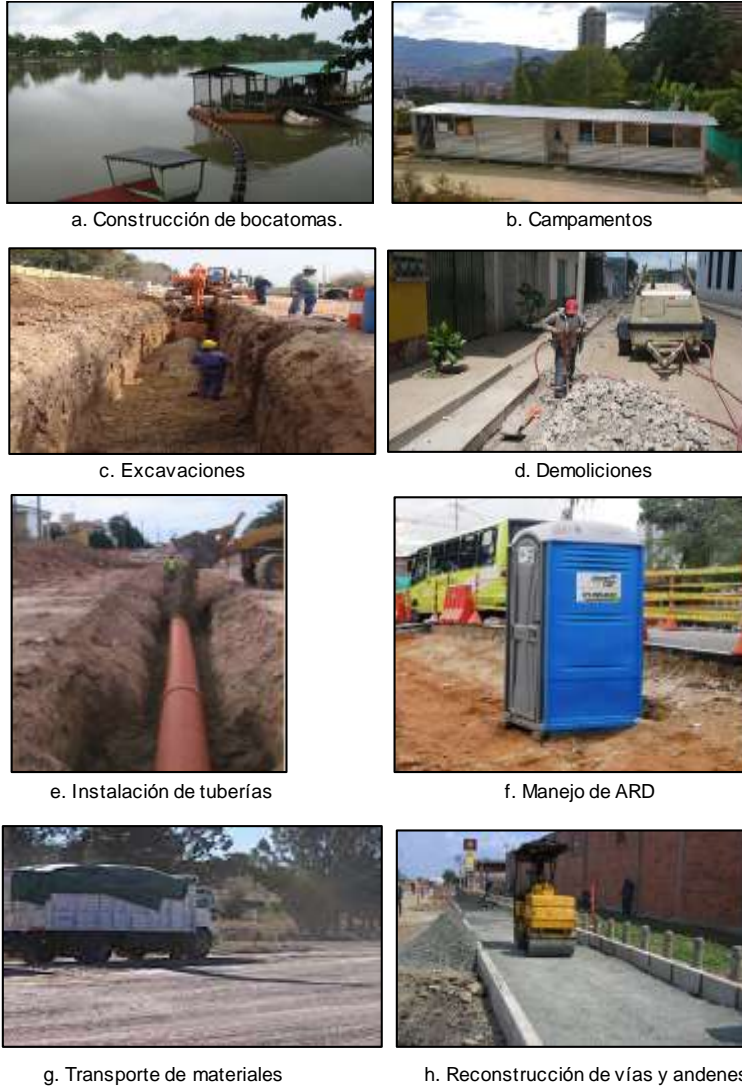
Figura 3-45 Algunas actividades tecnológicas de construcción de acueductos y alcantarillados
