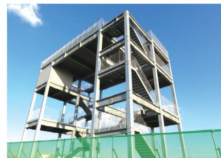
津波避難タワー (千葉県九十九里町) Tsunami Evacuation Tower (Kujukuri Town, Chiba Prefecture)
