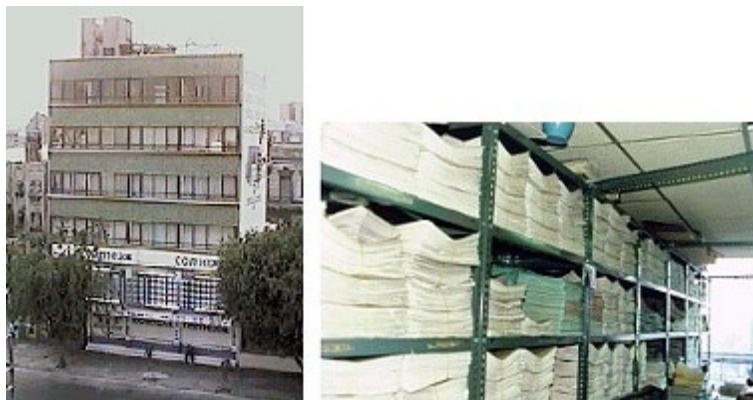
Edificaciones con sobre peso
