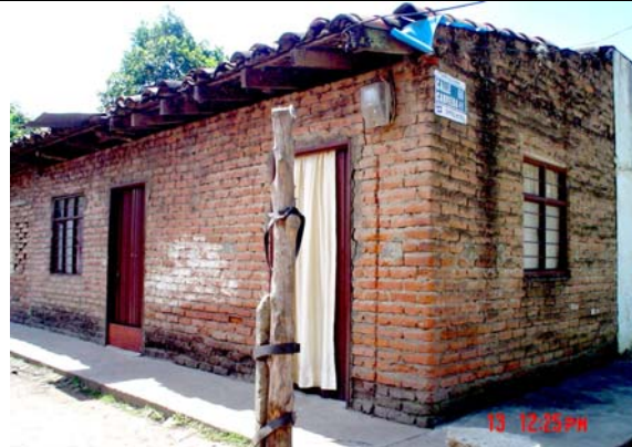
Mampostería simple 1P sin diafragma (Sistema 3B)
