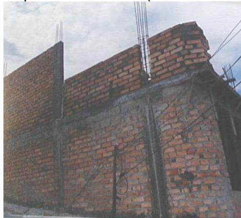
Mampostería confinada (con columnetas)
