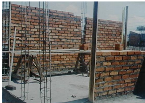
Mampostería confinada (con columnetas)
