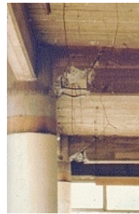
Vigas fundidas en sitio
