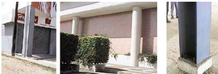
Columnas de concreto reforzado
