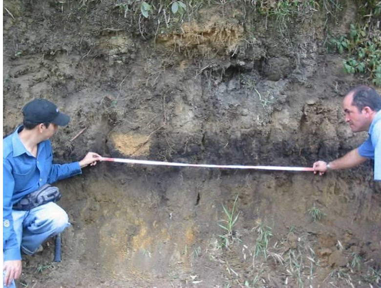
Foto 5.8 Talud sur de la vía, sector izquierdo de la Foto 5.7
