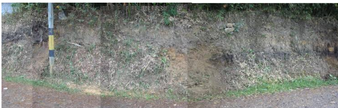
Foto 5.7 Talud sur de la vía
