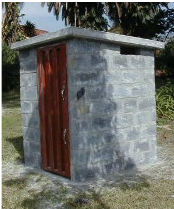
Foto 9.2 Caseta acelerográfica del Hogar de los Recuerdos en Itagüí
