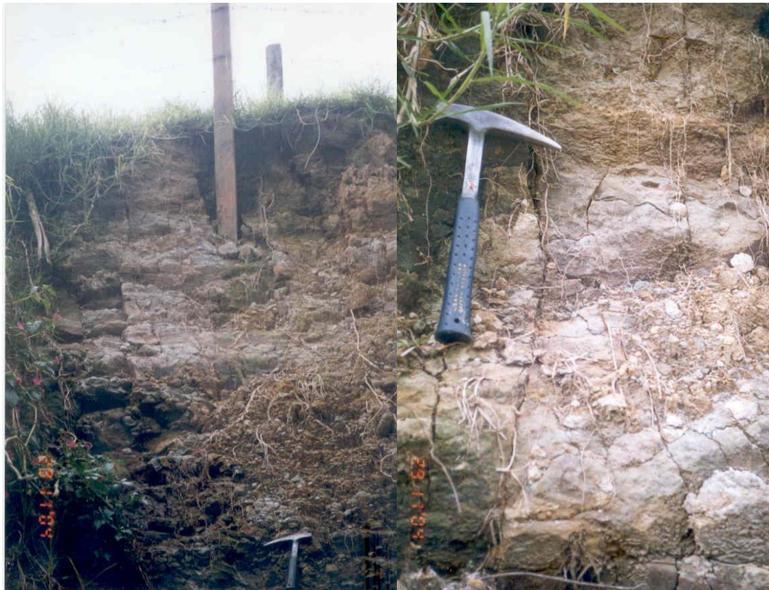
Fotos 5.1 y 5.2 Sitio localizado a 1,2 km del Mall de Caravanchel por la vía que de este sitio comunica con El Retiro
