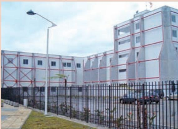
Foto 6: Reforzamiento Estructural en el Hospital de Caldas.
