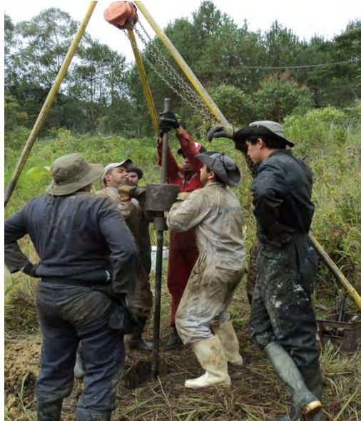
Fotografía 13. Perforación realizada en la zona de estudio
