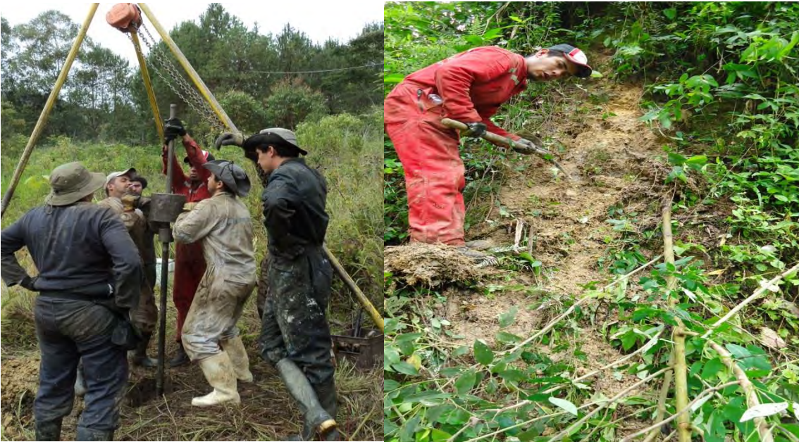
Fotografía 1. Exploración directa del subsuelo (SPT)
