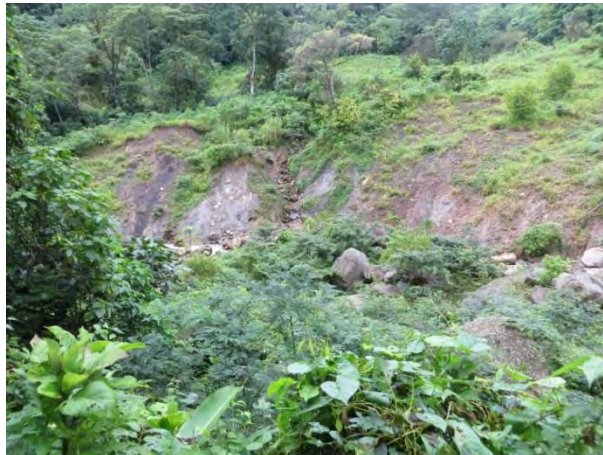
Fotografía 19. Zona afecta por el deslizamiento.
