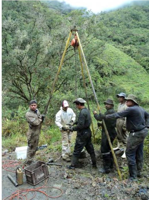
Fotografía 13. Perforación realizada en la zona de estudio
