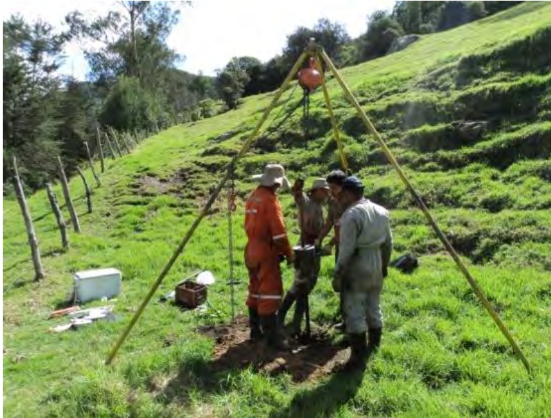
Fotografía 19. Perforación realizada en la zona de estudio
