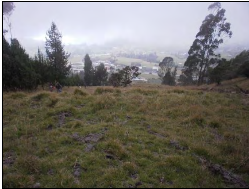
Fotografía 33. EN PARTE BAJA DEL DESLIZAMIENTO SE OBSERVA EL AREA URBANA DE VENTAQUEMADA
