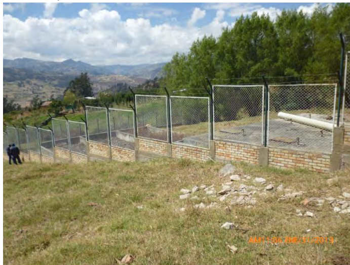
Fotografía 30. Infraestructura planta de tratamiento
