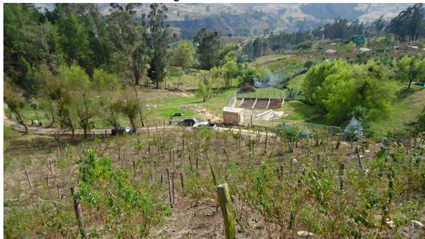
Fotografía 25. Planta de tratamiento de aguas.
