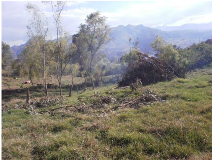
Fotografía 28. Inclínación de la cerca debido a la reptación.
