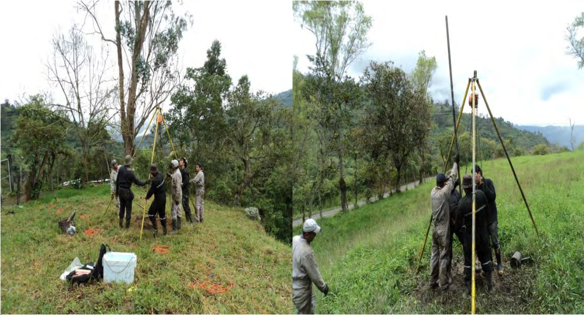
Fotografía 1. Exploración directa del subsuelo (SPT)
