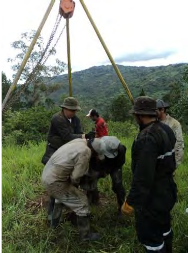
Fotografía 17. Perforación realizada en la zona de estudio
