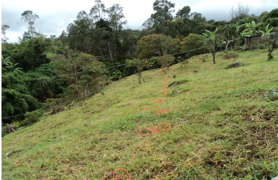
Fotografía 15. Parte alta del deslizamiento.
