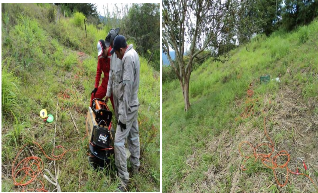
Fotografía 16. Parte media del deslizamiento.
