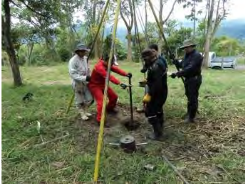
Fotografía 18. Perforación realizada en la zona de estudio
