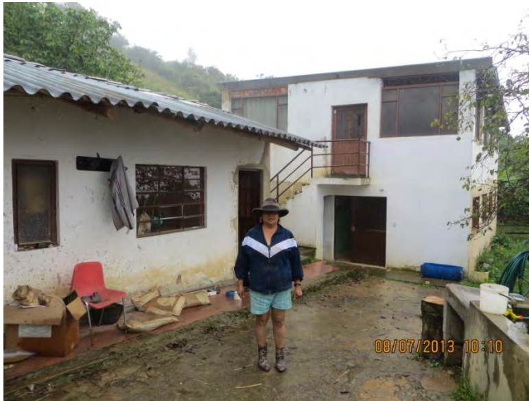
Fotografía 32. Familia con afectaciones en sus terrenos a causa del deslizamiento.
