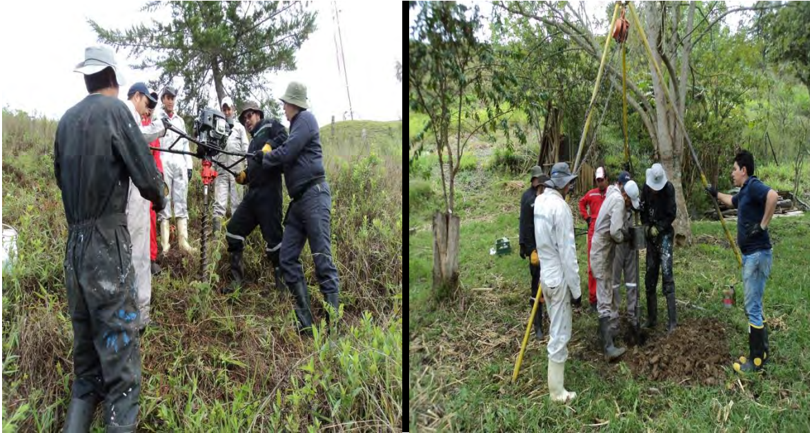
Fotografía 1. Exploración directa del subsuelo (SPT)
