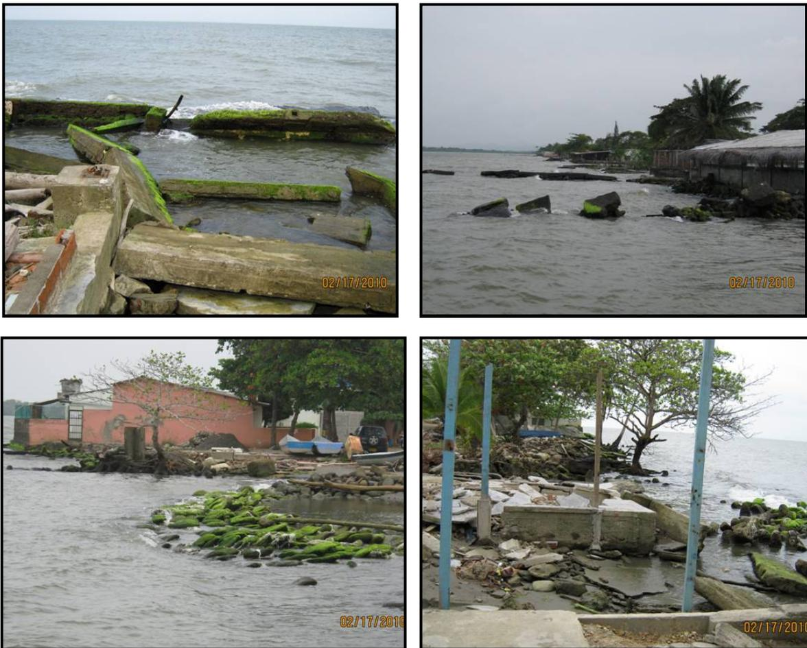
**Figura 4-12. Algunos ejemplos de obras artesanales deterioradas**
