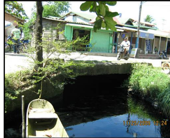
d) Vía aledaña al canal Puerto Tranca
