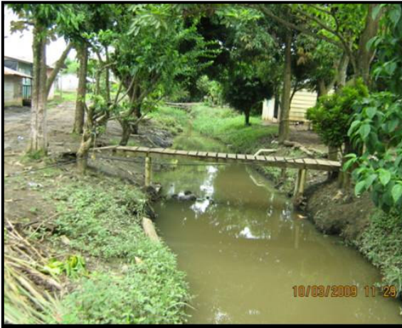
a) Tramo paralelo a la Calle 115
