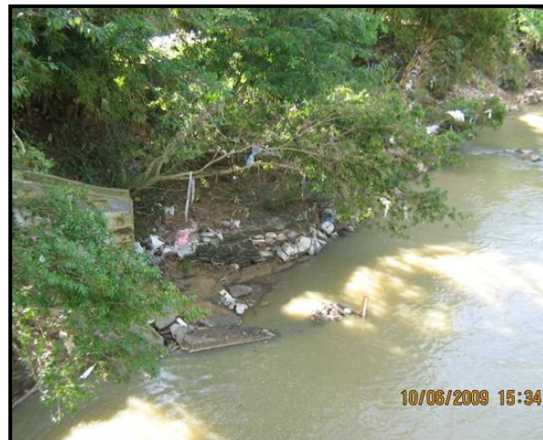
Figura 3-19. Depósito afectado por socavación lateral Río Chigorodó margen izquierda sector K1+950 a K2+050
