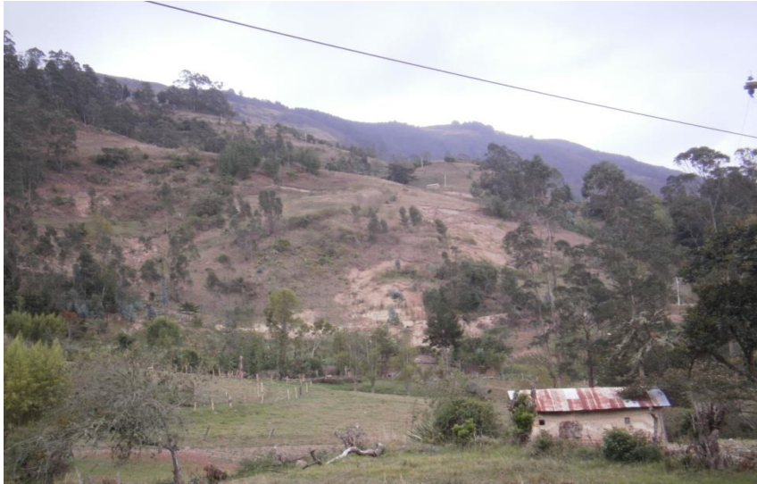
Fotografía 31. Viviendas ubicadas dentro de la zona de deslizamiento. Nótese el tipo constructivo utilizado
