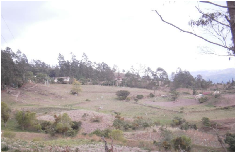
Fotografía 32. Viviendas ubicadas dentro del Deslizamiento
