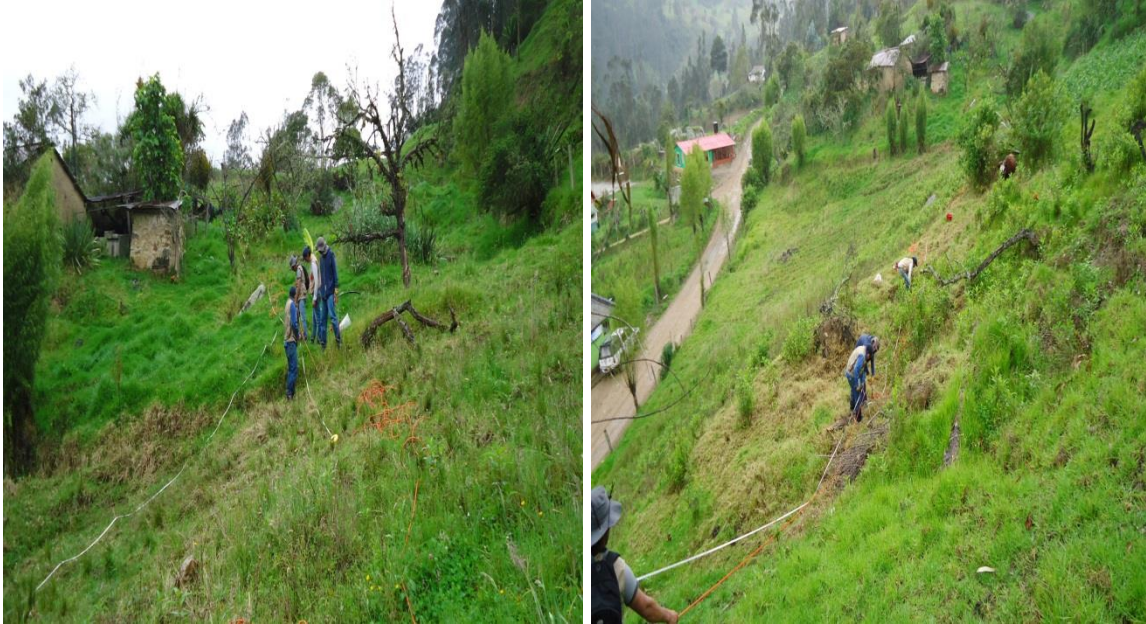
Fotografía 19. Parte media del deslizamiento.
