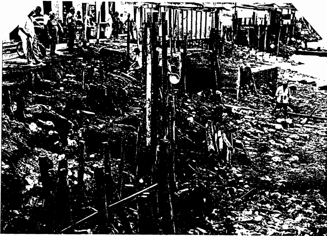
Foto 6. Borde casco urbano de Gamarra, orilla derecha río Magdalena. Fenómeno intenso de erosión y socavación. Obsérvese los restos de construcciones recientemente destruidas.
