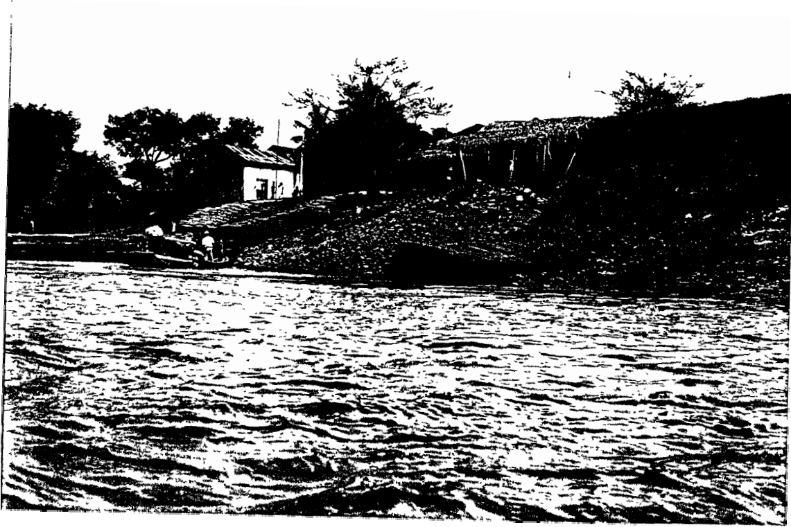
Foto 16. Borde casco urbano de Gamarra, orilla derecha rio Magdalena. sistemas rudimentarios de protección del talud.
