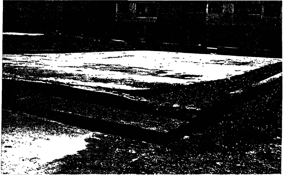
Figura 33. Asentamiento en placa de concreto construida sobre un relleno entrópico mal ejecutado. Parque de la Hermosa, quinta etapa.
