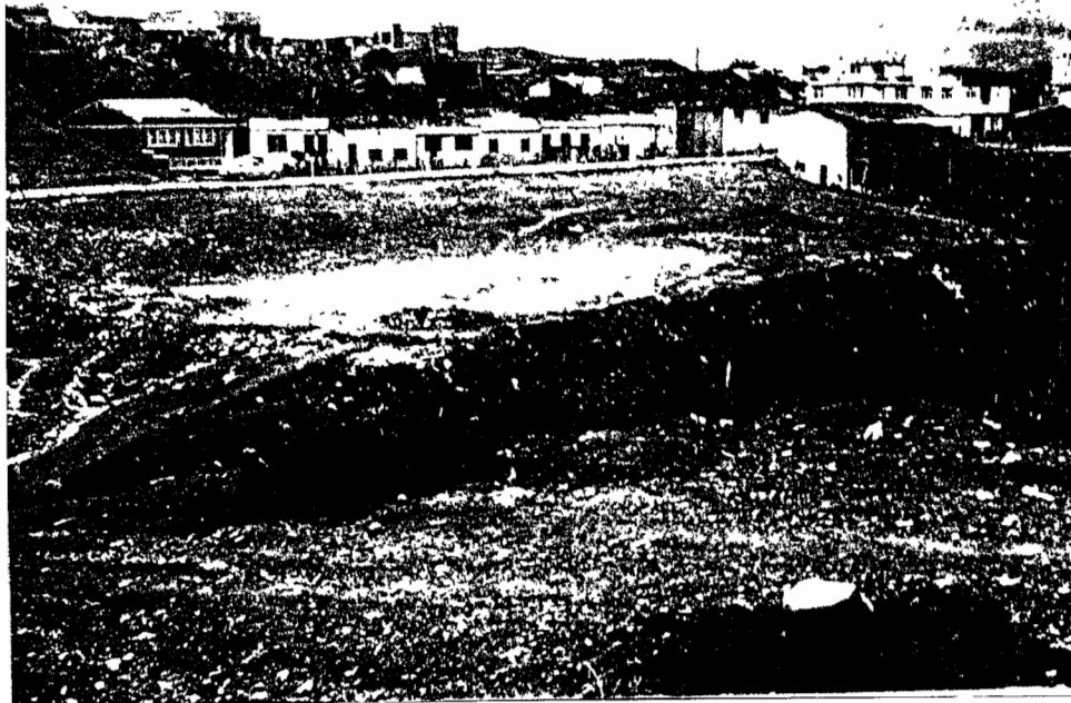
Figura 20. Aspecto del relleno artificial de la Quebrada "El Bollo".
