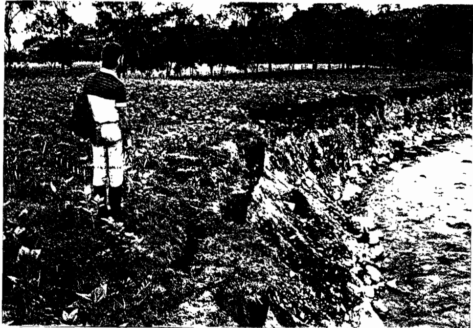
Figura 28. Socavación de orillas en la margen izquierda del Río San Eugenio (al frente de la calle 34). Este fenómeno ha provocado la pérdida de una faja de terreno de 8 metros de ancho en los últimos dos años.
