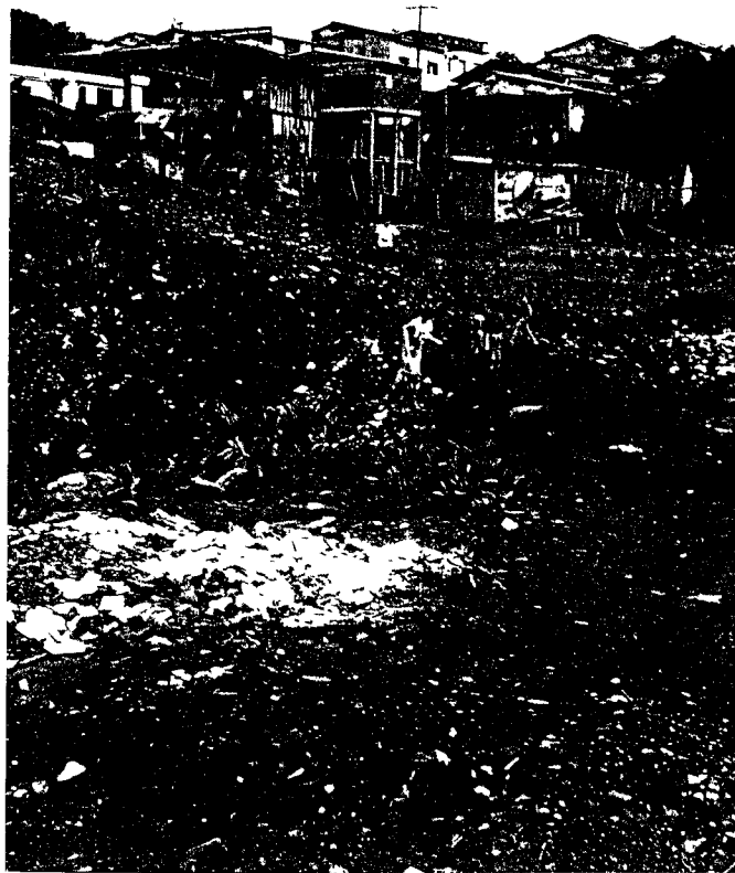
Figuras 21. Materiales empleados y forma de construcción del relleno antrópico de la Quebrada "El Bello" .
