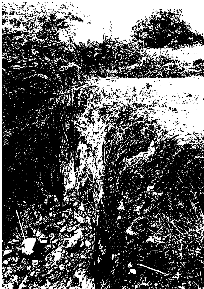
Figura 27. Caídas de cuñas de cenizas volcánicas ligadas a diaclasamiento (vertiente Este de la Quebrada San Roque, sector Los Bloques, La Hermosa). Detalle del diaclasamiento se muestra en la figura 7.
