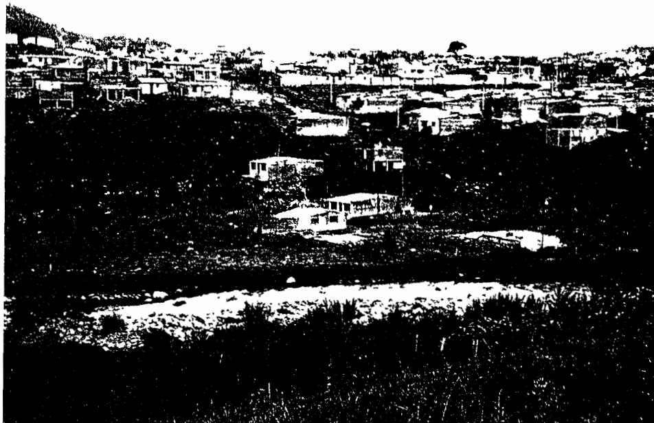
Figura 17. Viviendas localizadas en la llanura de inundación del Río San Eugenio.
