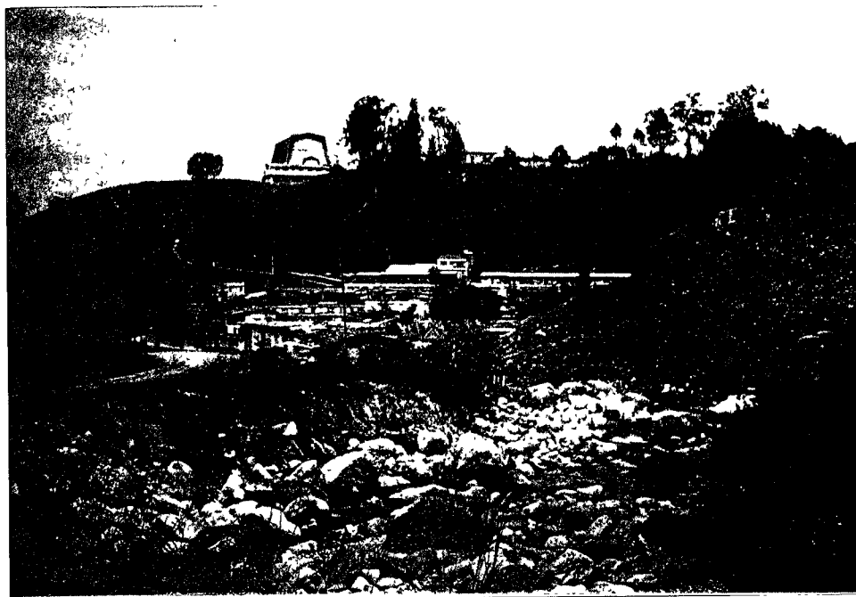
Figura 41. Aspecto de la Quebrada Santa Helena antes de su desembocadura. Obsérvese el deterioro general de vertientes y orillas y la indebida localización de las construcciones ribereñas.
