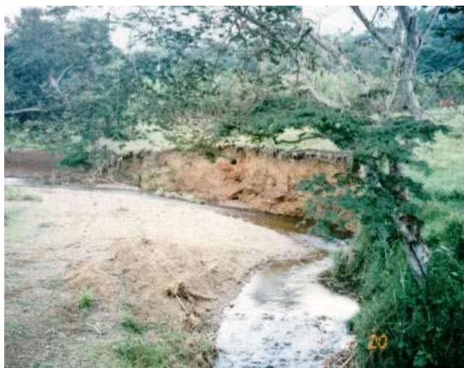
Figura 19. Socavación lateral de cauces sector plano
