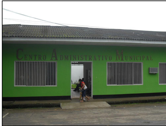
Figura 05. Centro administrativo municipal
