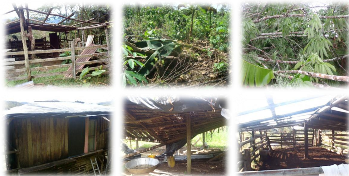
Figura 21. Daños y pérdidas por vendavales zona rural
