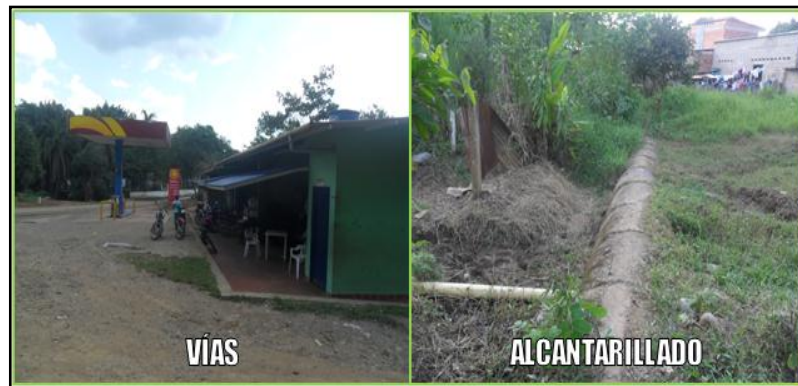
Figura 59. Redes presentes en la zona urbana afectada por explosión de combustibles
