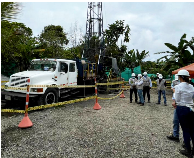
Obra pozo profundo Guapi
