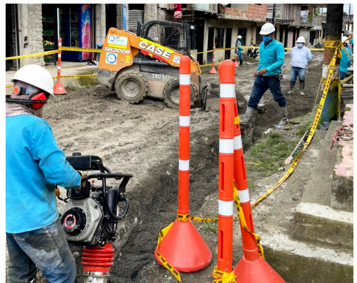
Actividades de perforación de pozo profundo e instalación de redes de distribución en el marco del proyecto de acueducto Fase 1 en Guapi, Cauca
