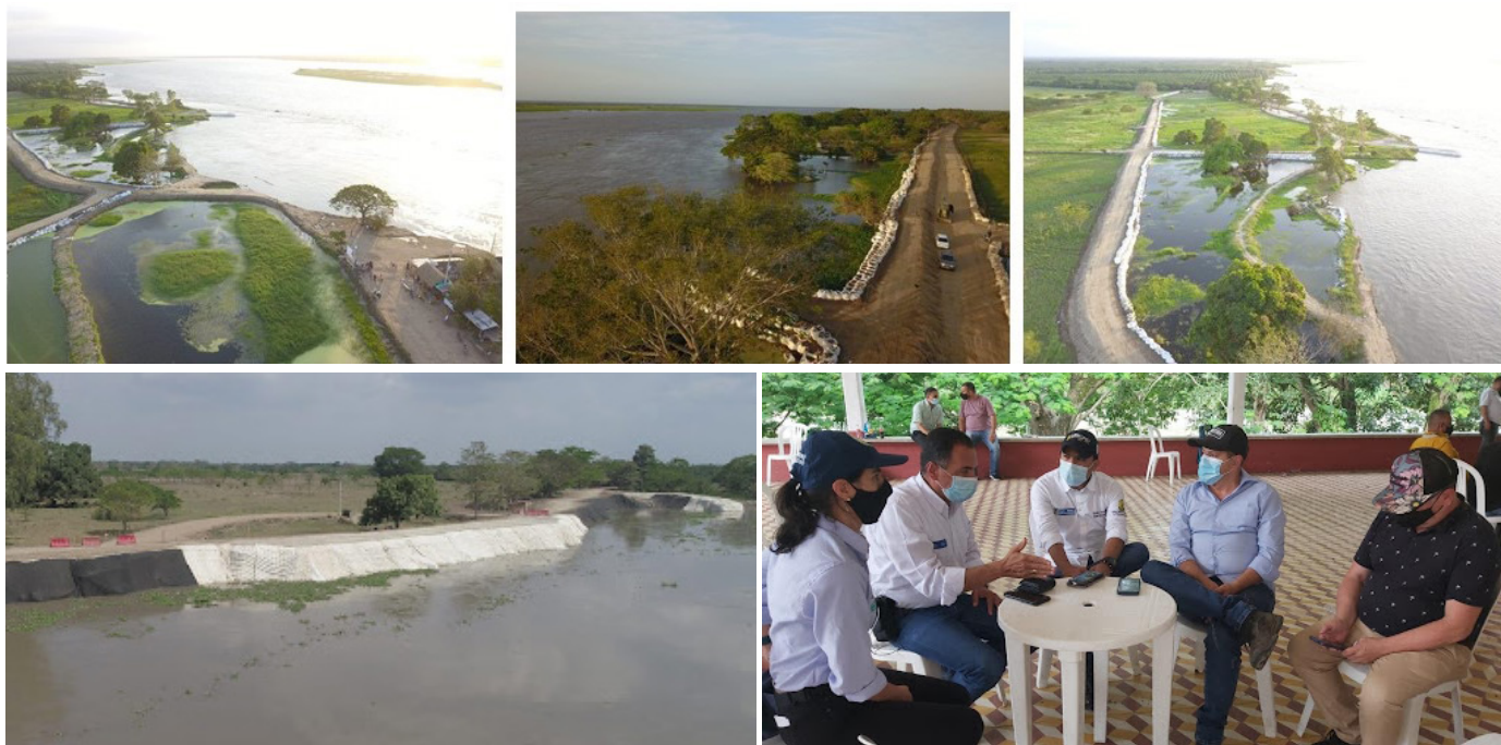
Obra de protección Salamina
