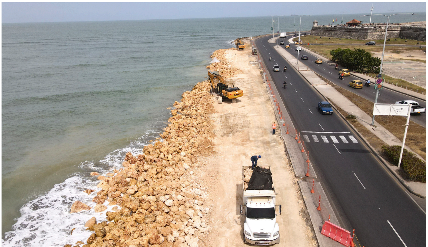
Obras proyecto Protección Costera Cartagena.
