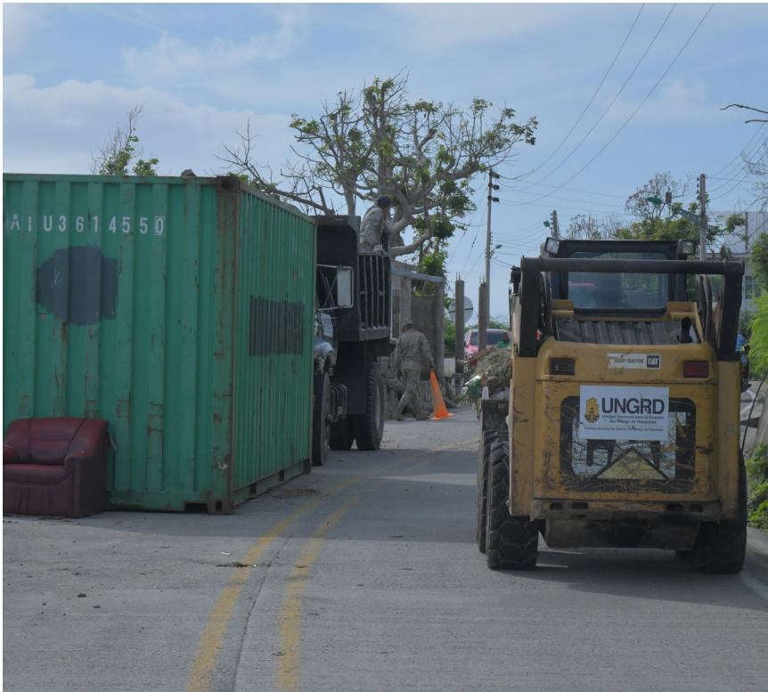
Remoción de escombros
