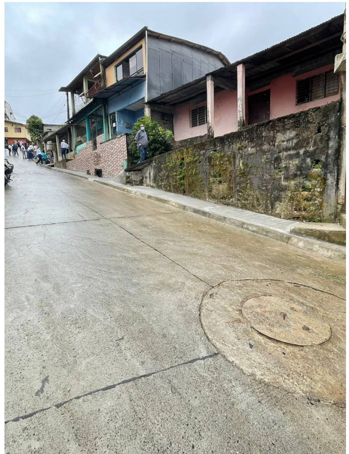
Obras de reposición de pavimento tras la instalación de redes de alcantarillado en el Barrio Minuto de Dios, Quibdó, Chocó
