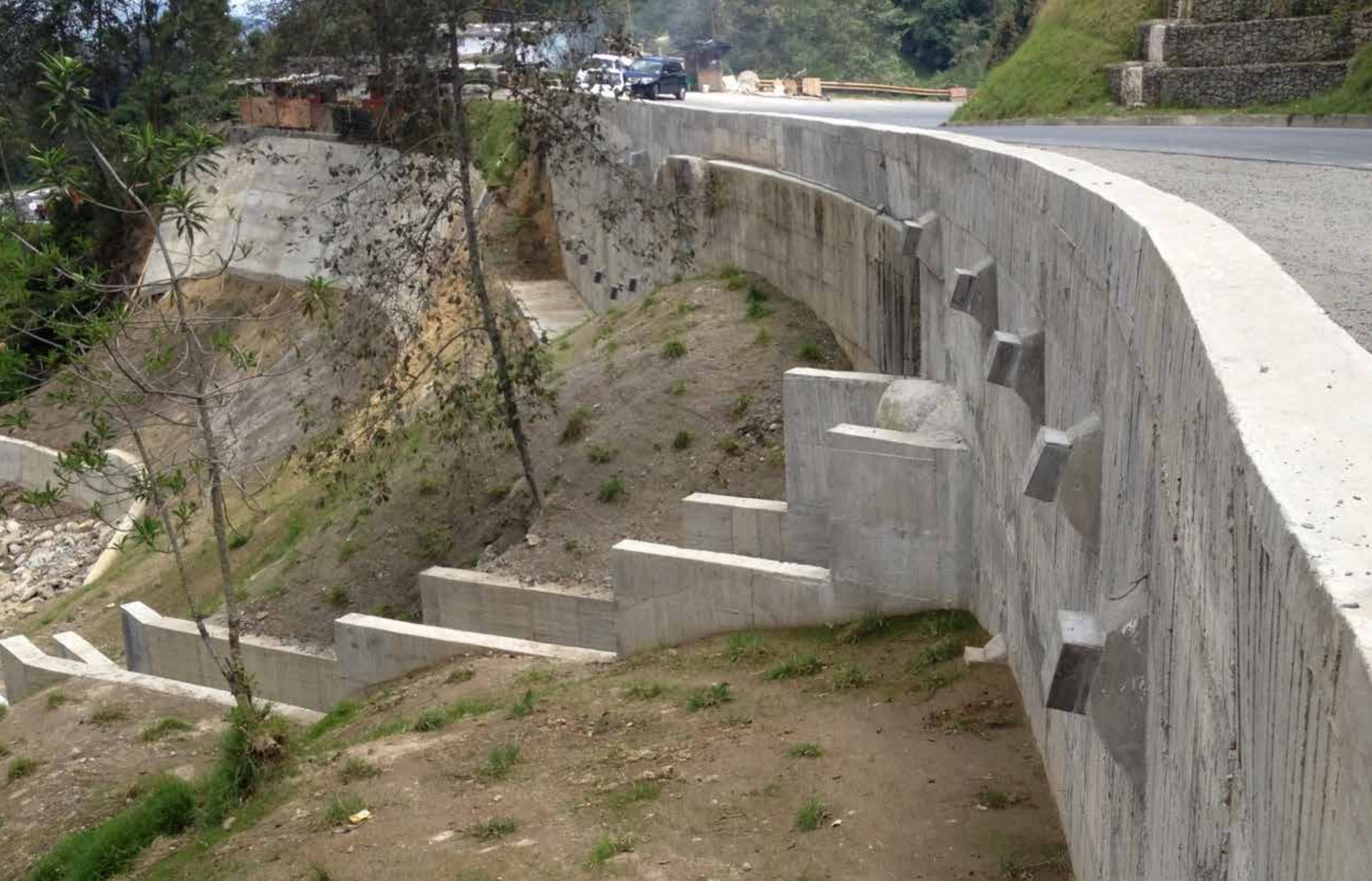
📷 Canalization works. Tres Puertas. La Libertad Bridge
