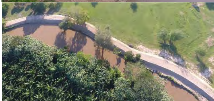
Obras control inundaciones Municipio Algarrobo Magdalena
