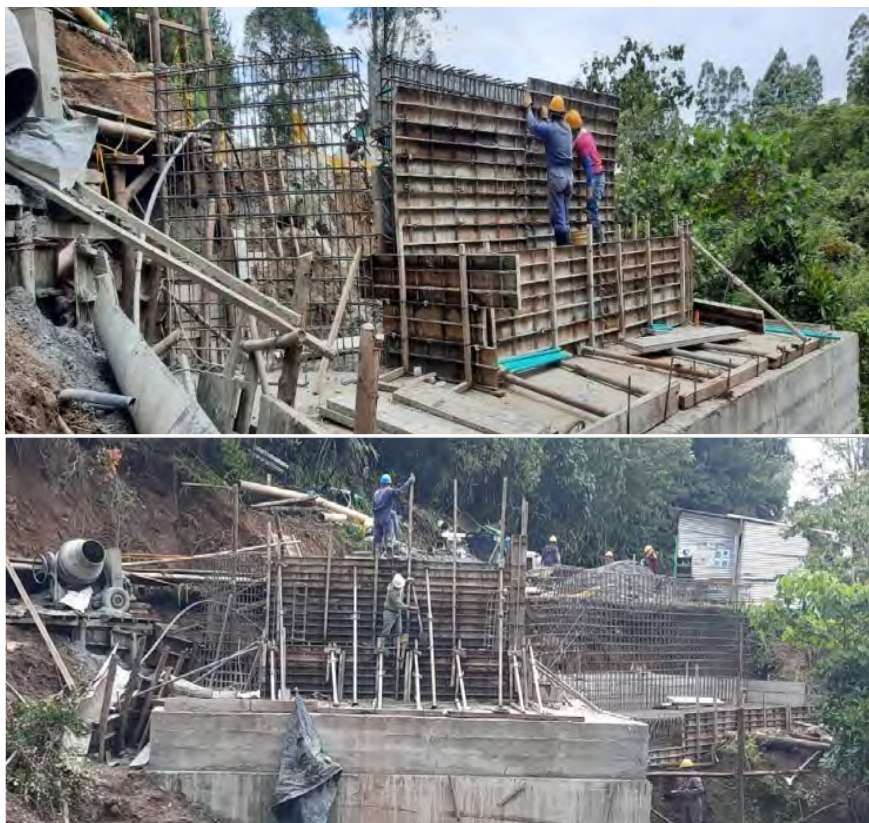
Construcción puente vehicular la Unión Nariño
