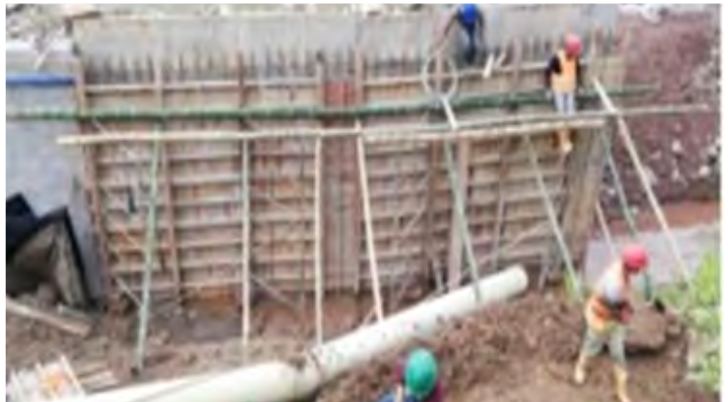
Avances en construcción de muro y filtro. - MURO BARRIO MODELO
