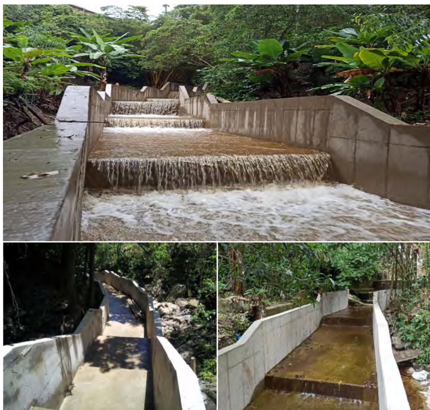
Obras de Mitigación Remoción en Masa Municipio La Belleza Santander
