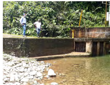
Obras de agua y saneamiento Buenaventura
