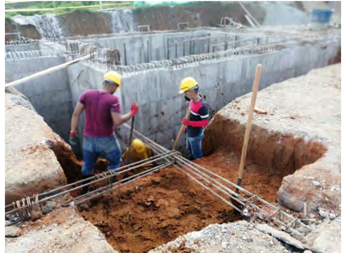
Fundición de vigas, columnas y tanques subterráneos. Fundición de columnas bloque bachillerato y primaria. - MEGACOLEGIO
