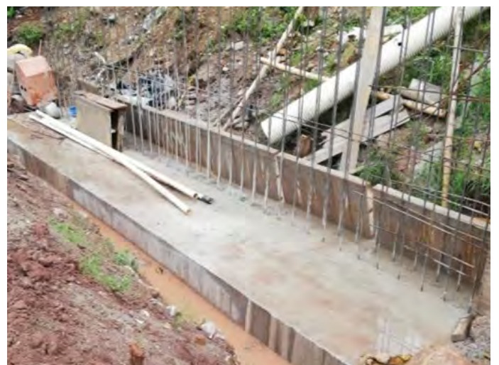
Construcción de bordillos perimetrales para confinamiento de terreno compactado. - MEGACOLEGIO
