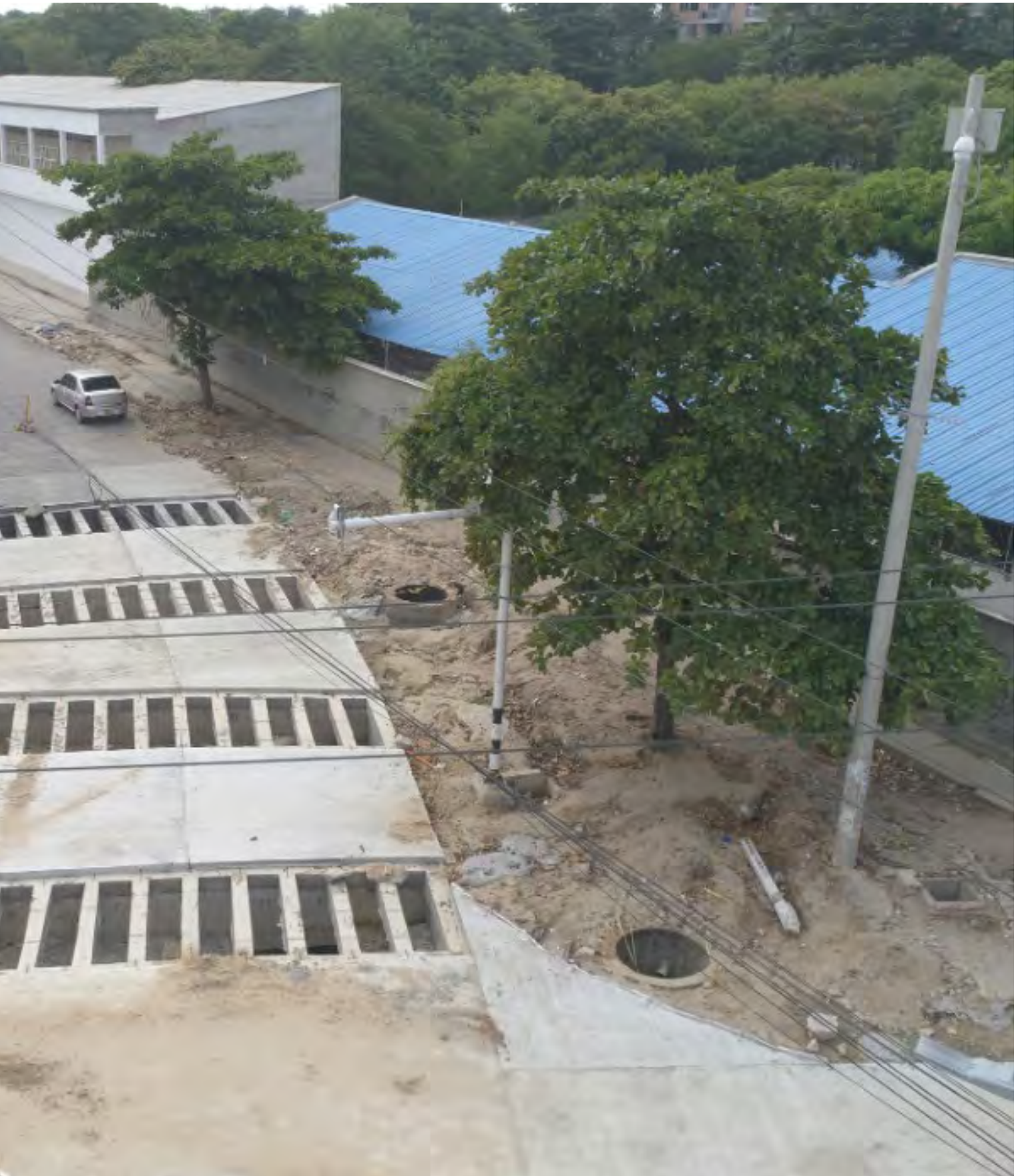
Obras de canalización arroyos, Barranquilla – Atlántico
