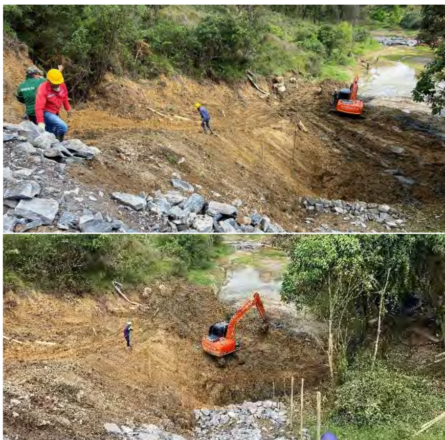
Obras de Mitigación Remoción en Masa Municipio La Belleza Santander
