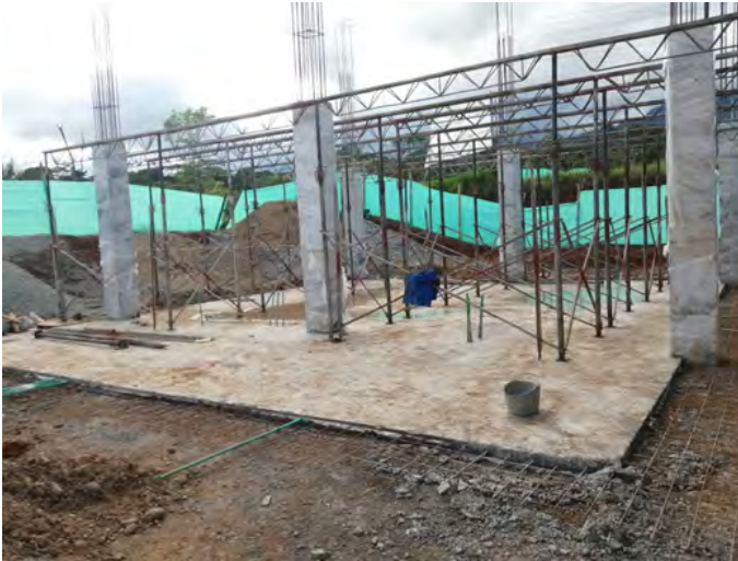
Fundición de vigas, columnas y tanques subterráneos. Fundición de columnas bloque bachillerato y primaria. - MEGACOLEGIO
