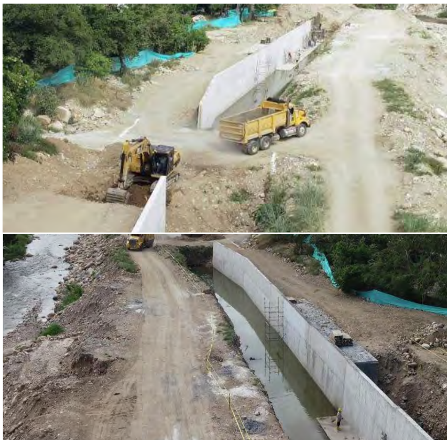
Obras control cauce y mitigación Río las Ceibas - Neiva
