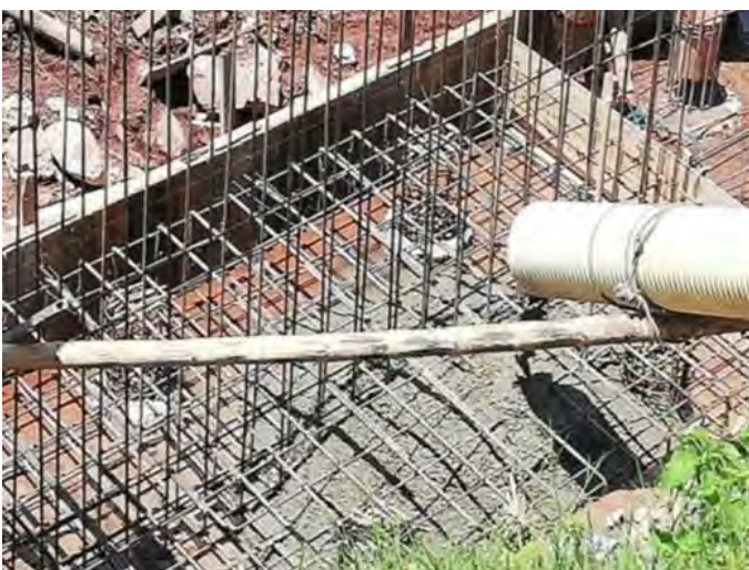
Fundición de pilotes en concreto reforzado. - MURO BARRIO MODELO
