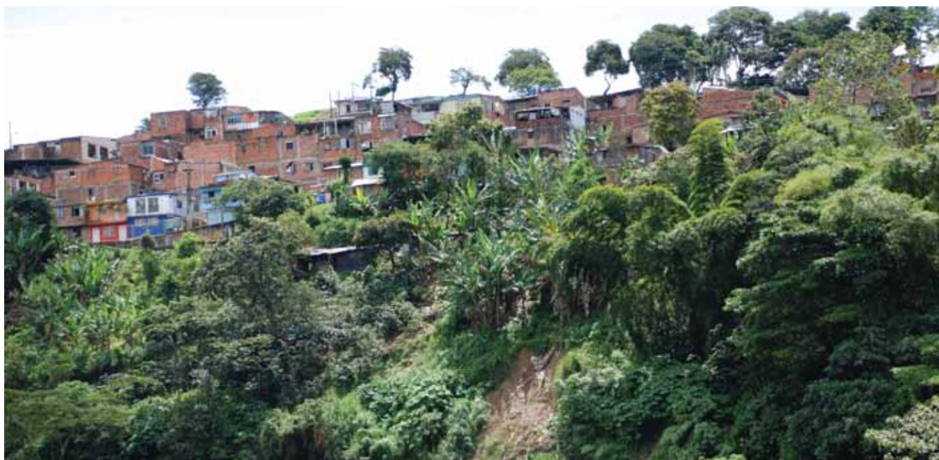
Deslizamiento. Municipio de Pereira (Risaralda), 2011. Fotografía cortesía de: Javier García Jaramillo
