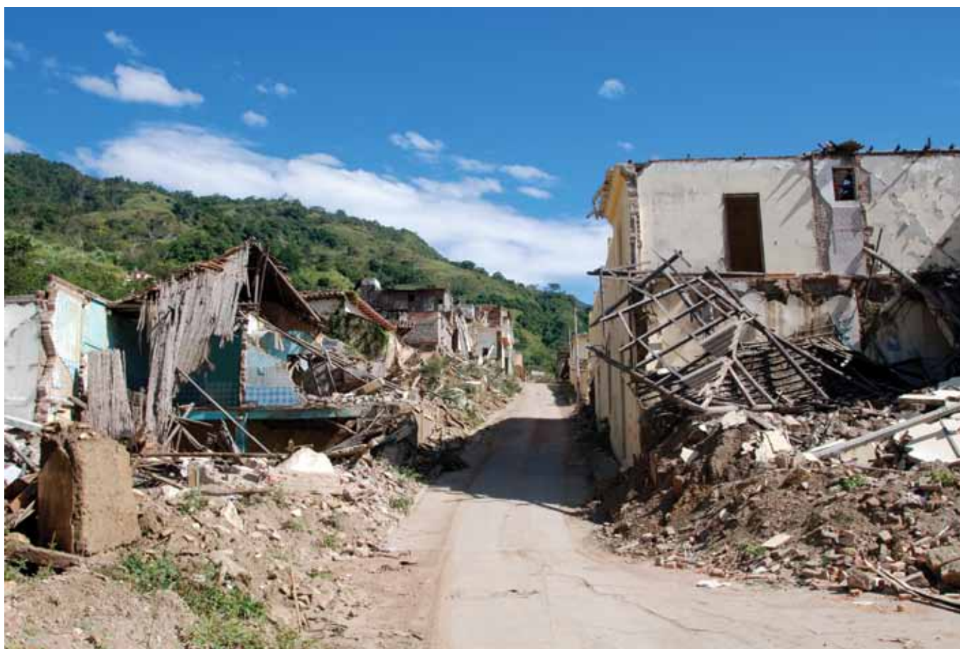
Viviendas destruidas por movimientos en masa. Municipio de Gramalote (Norte de Santander), 2011. Fotografía cortesía de: Gabriel Jaime Arango Zapata.
